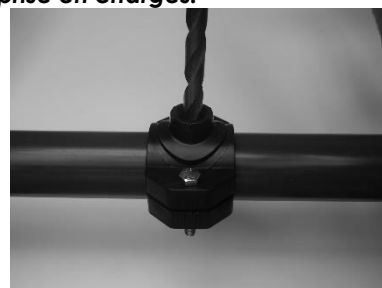
Figure 20 : Perçage du tuyau.
