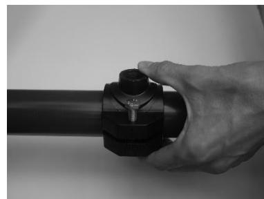
Figure 18 : Pose du collier de prise en charges.
